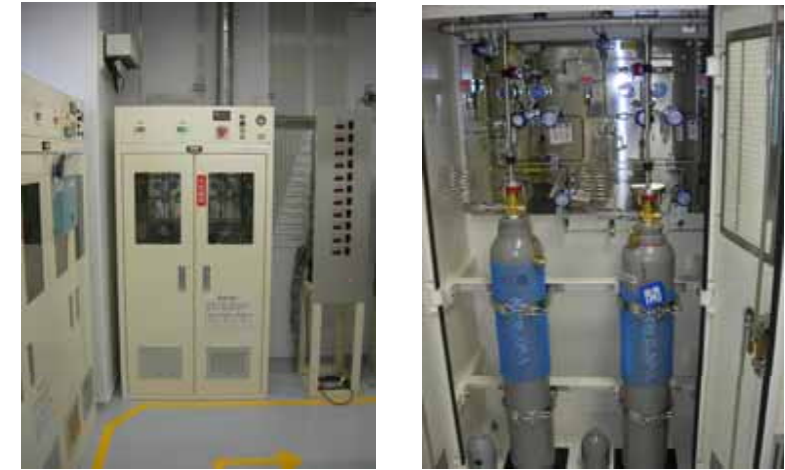
シリンダーキャビネット(参考外側寸法) 7m3(47L)ポンペ(1本) W500×D500×H2200 7m3(47L)ポンペ(2本) W1000×D500×H2200 1m3(10L)ポンペ(1本) W500×D400×H1800
